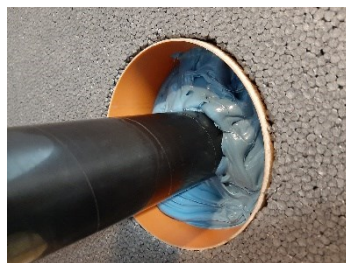
Aplikace Anticor Seal při průchodu základovým věncem
