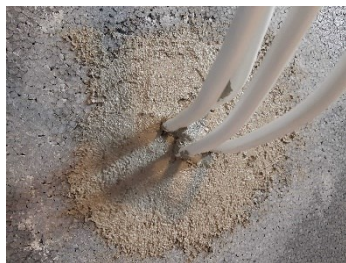
Aplikace Anticor Seal při průchodu základovým věncem
